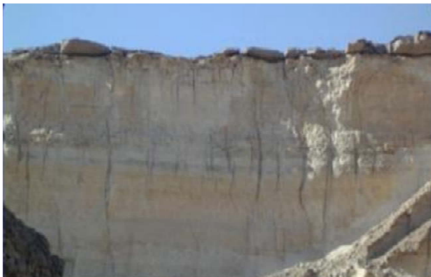
Figura 1.11: Corredor de fraturas em afloramento carbonático.
