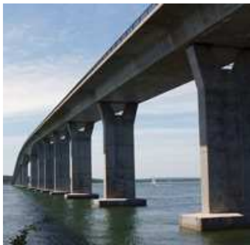
Figura 2.7 – Reabilitação de ponte utilizando CFC ( http://www.compositesworld.com/ct/issues/2006/April/1240 ).
