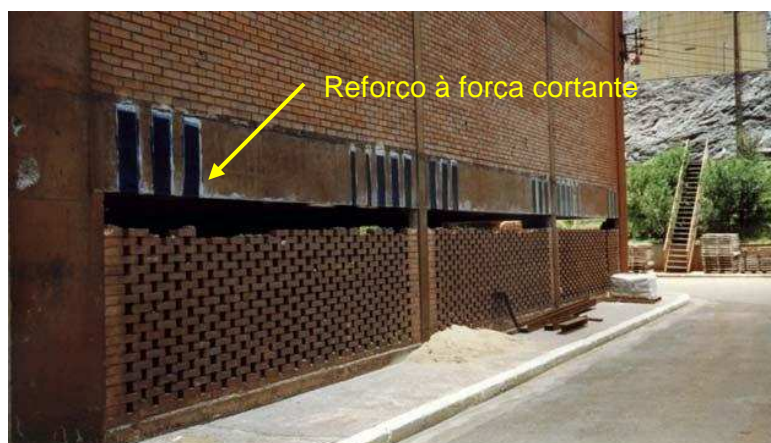
Figura 2.10 – Reforço á flexão e à força cortante de viga externa do Edifício da Alcan Alumino do Brasil em Ouro Preto
