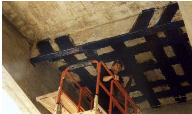
Figura 2.8 – Laje e viga reforçada no viaduto de Santa Tereza
