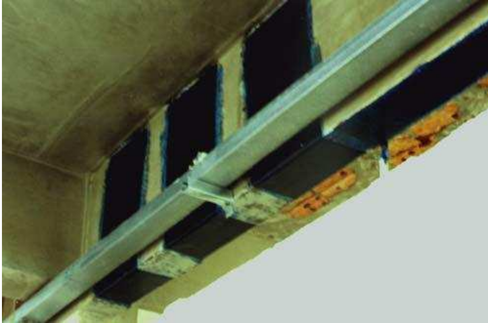
Figura 2.15 – Reforço da viga à flexão e à força cortante na Fundação Mineira de Educação e Cultura – FUMEC
