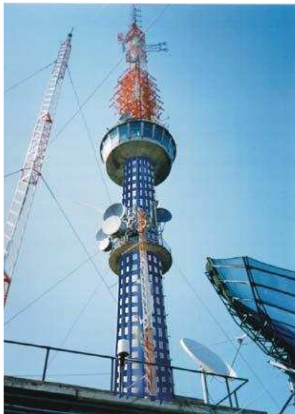
Figura 2.12 – Reforço da Torre da Rede Globo de Televisão no Rio de Janeiro RJ
