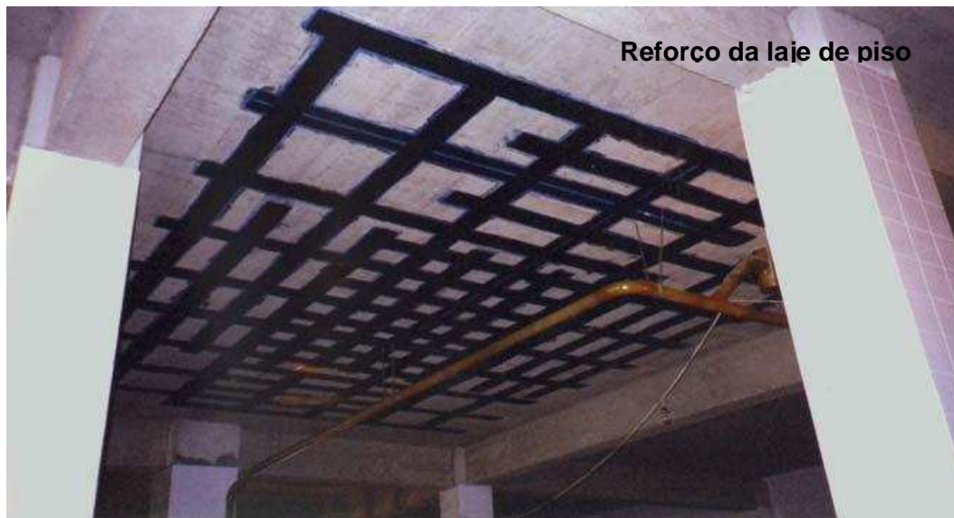
Figura 2.13 – Fábrica de Laticínios Itambé em Sete lagoas MG ( http://www.cesec.ufpr.-Br/pet/titulo/biblioteca/seminarios/arquivo_seminarios/construcao_civil/reforco_estrutural_com_fibras_de_carbono.pdf ).
