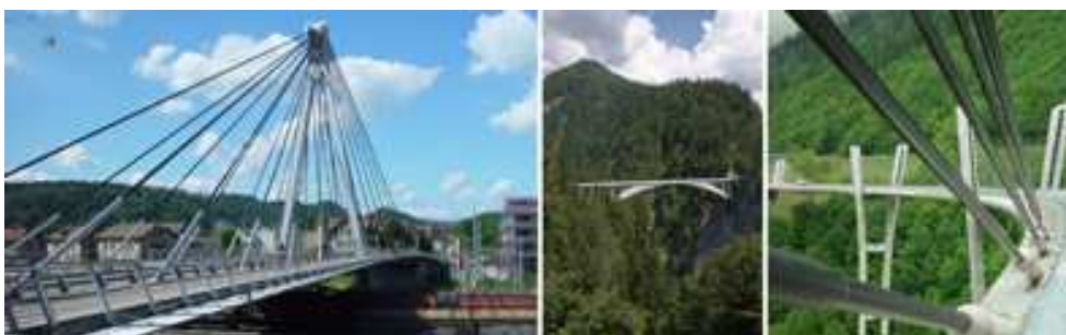
Figura 2.5 – Ponte Storchen na Suíça
