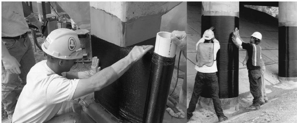
Figura 2.11 – Reforço de pilares retangulares e de colunas
