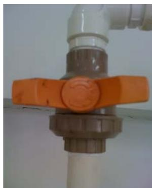
Figura 15 – Válvula de controle da vazão.
