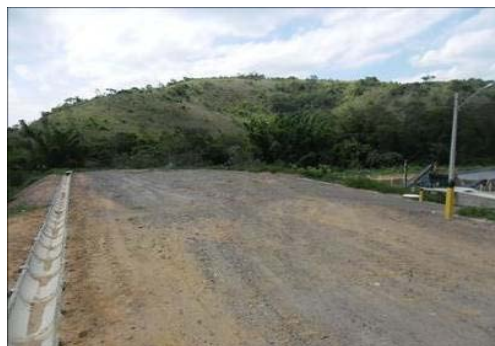
Área de armazenamento primário de Resíduo Sólido de Entulho. Fonte: Consórcio N/I. Relatório nov/2012.
