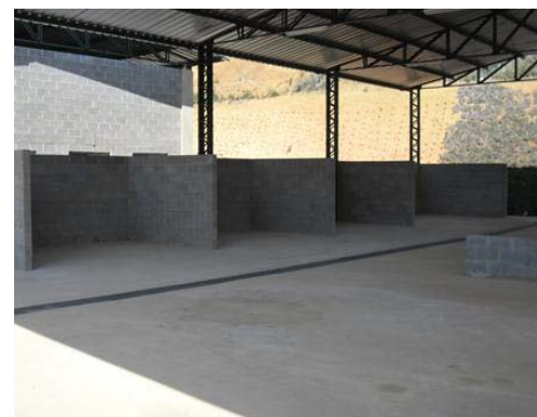
Baixas para separação de pilhas e baterias e pneus. Fonte: Consórcio N/I. Relatório nov/2012.
