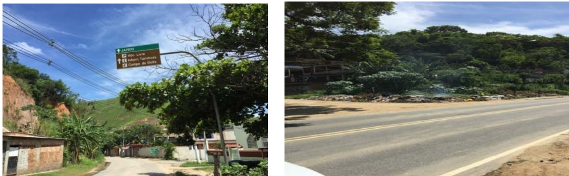
Figura 13 – Uma das entradas de Japeri com limpeza pública satisfatória (à esquerda) e deposição inadequada de resíduos em uma via interna (à direita). Centro do Distrito-Sede. Visitado em 22/12/2016. Fotos: Autoria própria.
