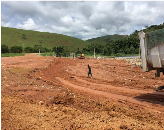
Vista do Aterro e chegada de um caminhão com resíduos Fonte: Concessionária. Jan/17.
