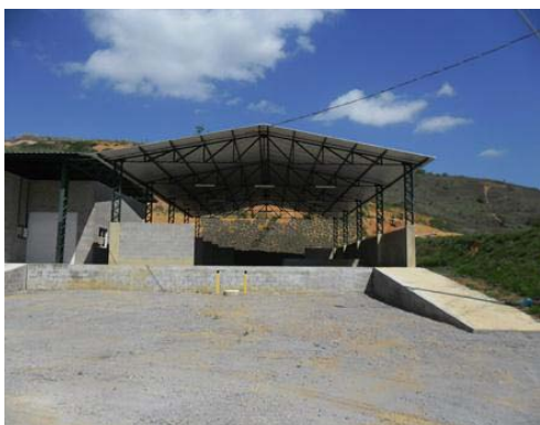
Vista do galpão. Fonte: Consórcio N/I. Relatório nov/2012.
