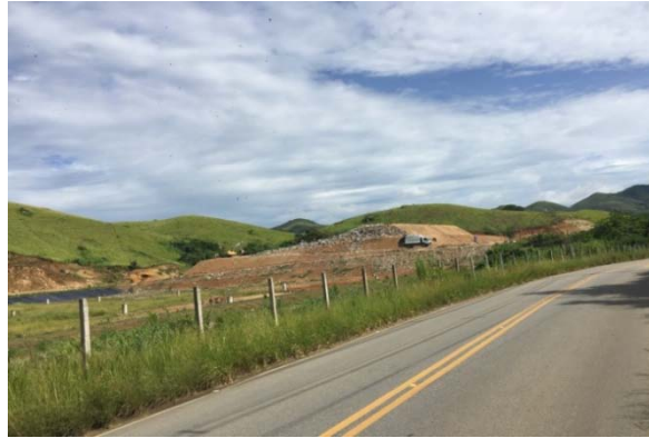
Figura 14 – Vista panorâmica do CTDR Paracambi. Visitado em 16/01/17. Fotos: Autoria própria.
