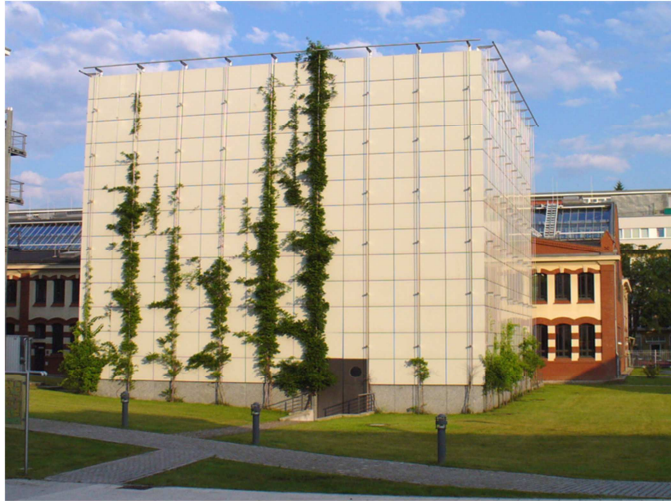
Figura 10 — Parte externa do prédio que abriga a Câmara blindada BMSR-2 [50].
