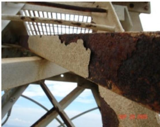
Figura 4.4 – Fenômeno de Dano por Corrosão.
