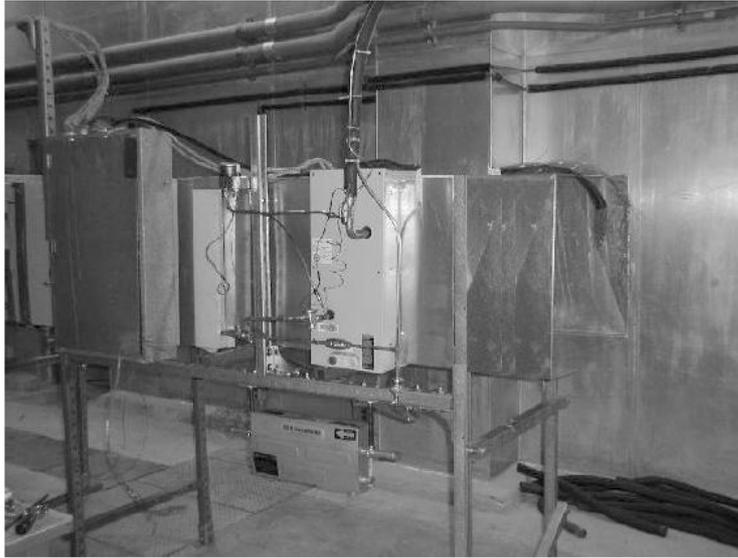
Figura 33. Unidade evaporadora para o sistema comercial da Lennox - modelo HSX19.
