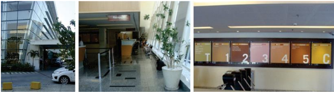
Figura 128 - Campo visual do Hospital Perinatal Barra – pontos 1, 2 e 3 Fonte: A autora
