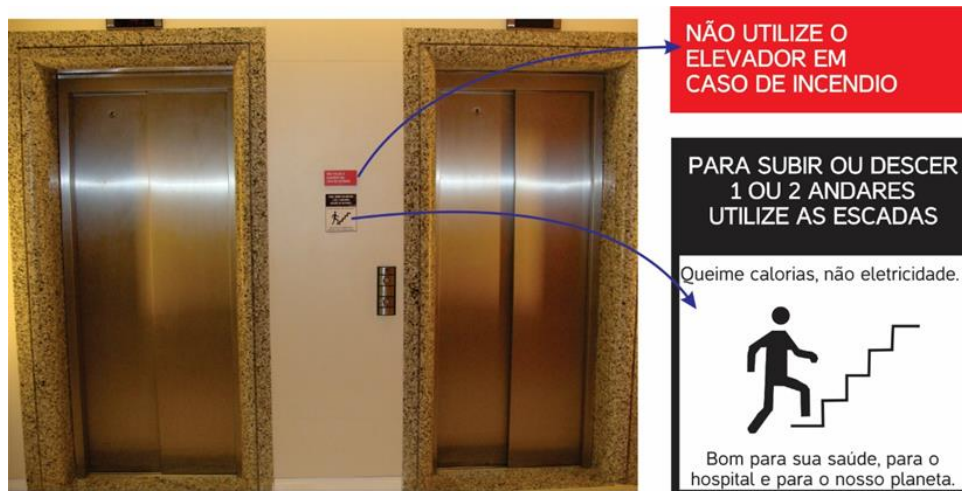
Figura 56 - Placa de advertência na parede entre as portas dos elevadores do Hospital Pro Criança Cardíaca Fonte: A autora
