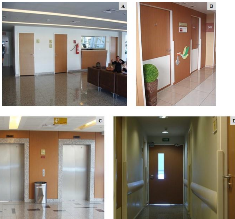
Figura 82 - Portas do Hospital Perinatal Barra: (A) dos banheiros no ambiente de estar do primeiro andar, (B) das suítes, (C) dos elevadores com espalas em granito cinza, (D) da área interna do setor de diagnósticos no térreo Fonte: A autora
