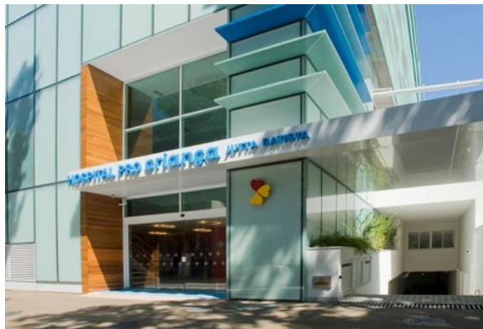
Figura 47 - Informações para identificação do edifício do Hospital Pro Criança Cardíaca Fonte: A autora
