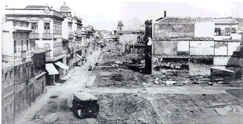
Figura 17: Demolições na área central da cidade
