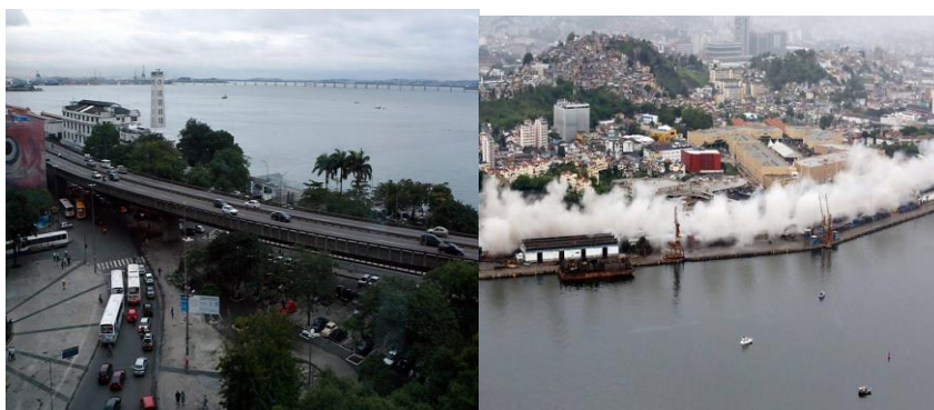
Figura 40: Avenida Elevado da Perimetral
