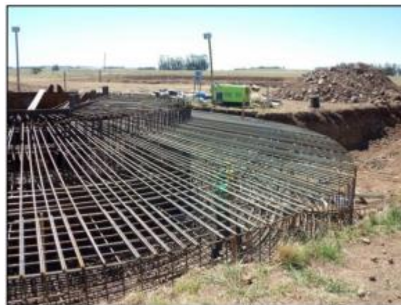
Figura 2.14 – Base circular dos aerogeradores do parque 3 do Complexo Eólico Cerro Chato, RS (MASSA CINZENTA, 2011).
