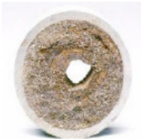
Figura 2-1 – Depósito de parafina obstruindo linha de transporte de petróleo (CENPES/PETROBRAS apud Cabanillas, 2006).
