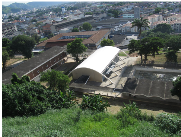
Imagem 38: A escola e os edifícios incorporados, vistos do terceiro pavimento do bloco A
