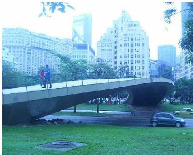
Imagem 12: Viaduto Paulo Bittencourt
