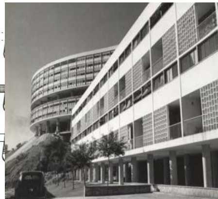
Imagem 26: Fachada frontal do edifício B2.
