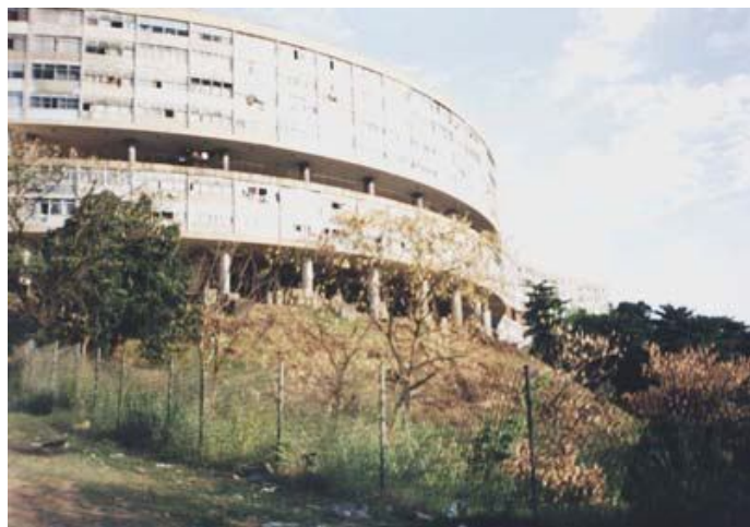
Imagem 31: Fachada frontal do bloco A
