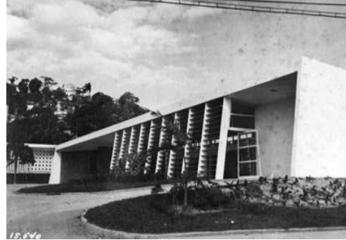
Imagem 29: Fachada do edifício do mercado/lavanderia.
