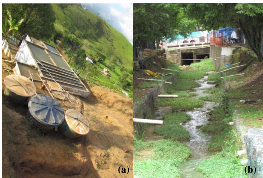
Figura 1. (a) Estação de tratamento e água em condições precárias (b) Esgoto despejado “in natura”
