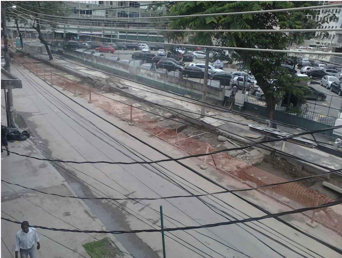
Ilustração 11: As escavações na Rua Sacadura Cabral.
