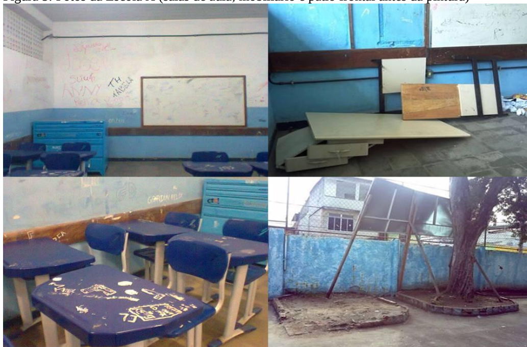
Figura 5: Fotos da Escola X (salas de aula, mobiliário e pátio frontal antes da pintura)
