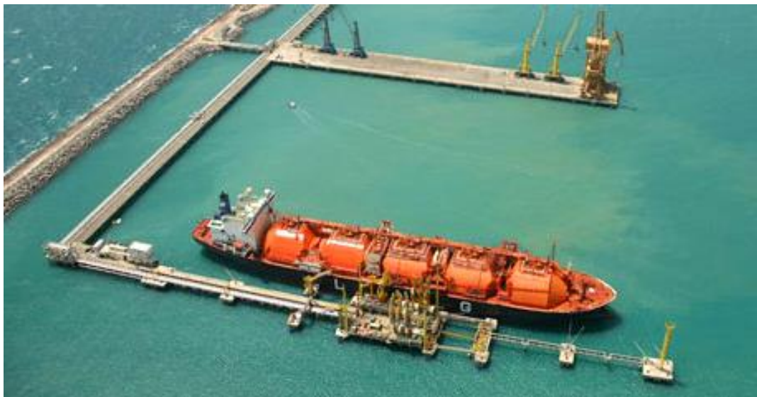
Figura 4.6: Terminal de regaseificação em Pecém, no Ceará. Fonte: Petrobras (2008).
