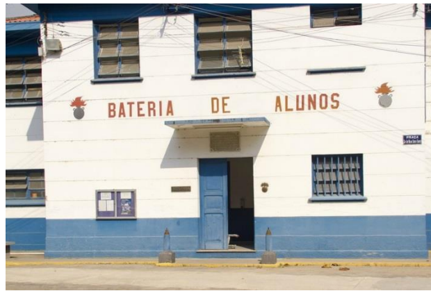
Figura 3: Prédio da Bateria de Artilharia (BiaArt)
