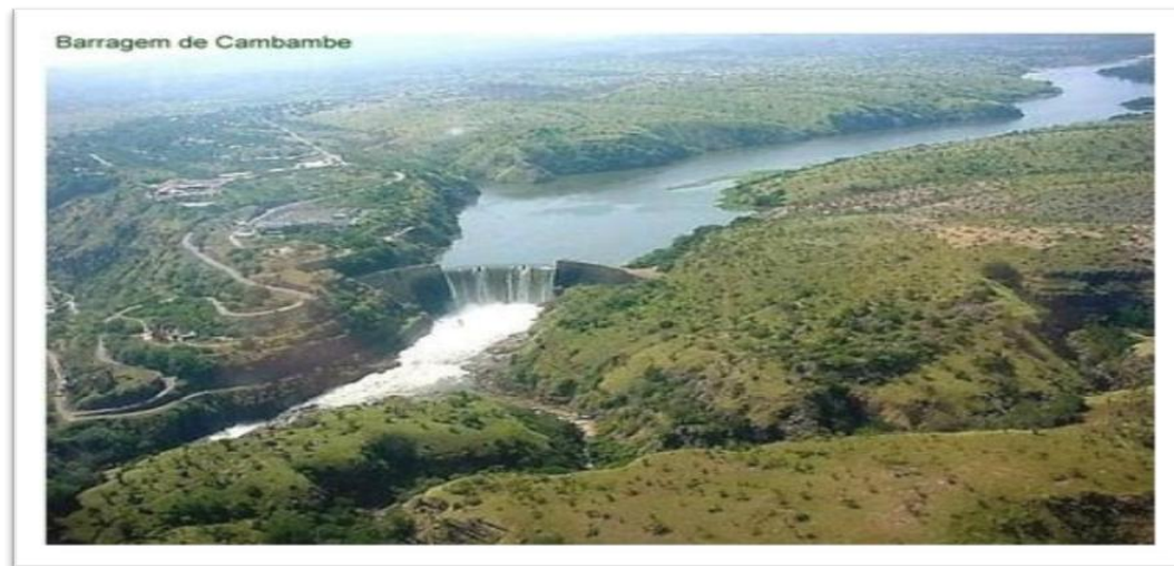
Figura 3.2 - Barragem de cambambe.
