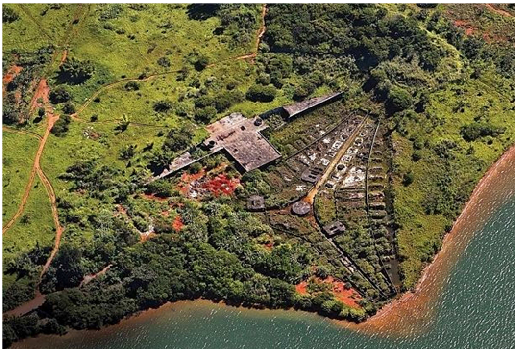
Figura 121: Sergio Bernardes, Escola Superior de Guerra, DF, 1970/74. Imagem “Ruínas da UNB”, estruturas de concreto remanescentes da obra abandonada da ESG (Imagem / matéria de 2014). Fonte: http://vejabrasilia.abril.com.br/materia/cidade/os-segredos-dos-escombros Acesso em: 24/03/2016.
