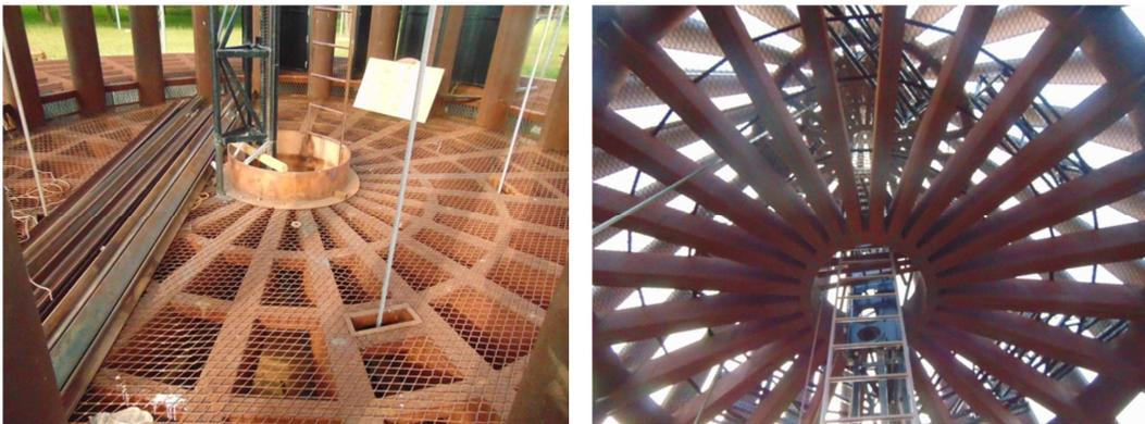
Figuras 41 e 42: Sergio Bernardes, Mastro da Bandeira, Brasília, 1972. Detalhes: Diafragma da base (esquerda) e 1º diafragma superior (direita). Sob o piso em tela metálica (enterrado) fica o mecanismo de hasteamento da Bandeira. Fonte: fotografado pelo autor (janeiro 2015).
