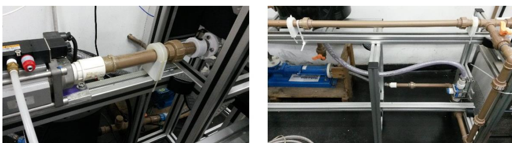
Figura 5.3 - Vista da tubulação e estrutura da bancada, mostrando o detalhe dos suportes de polipropileno.
