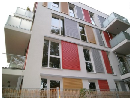
Fotos 81 – Edifício em Munique com esquadrias de correr externas (fonte: Autor).
