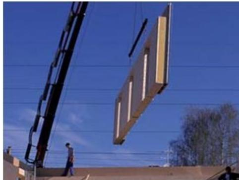
Figura 27 – Montagem no local da obra (fonte: Website TES EnergyFaçade<sup>113</sup>).
