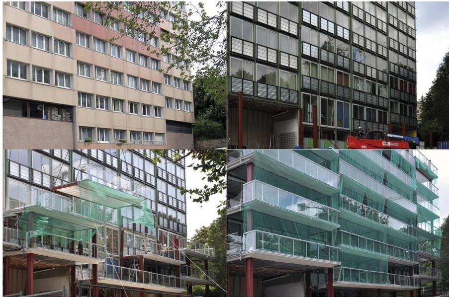
Figura 39 – Alteração esquadrias e execução das varandas. Fachada antes da renovação (alto esquerda), com substituição das esquadrias e com proteção em função da ausência das varandas (alto direita), durante a instalação das varandas (abaixo esquerda); na conclusão das varandas (abaixo direita) (fonte: Website Lacaton & Vassal<sup>123</sup>).
