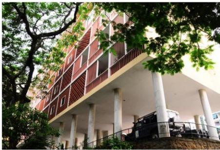
Figura 10 – Foto Pilotis Edifício Caledônia (fonte: Autor).
