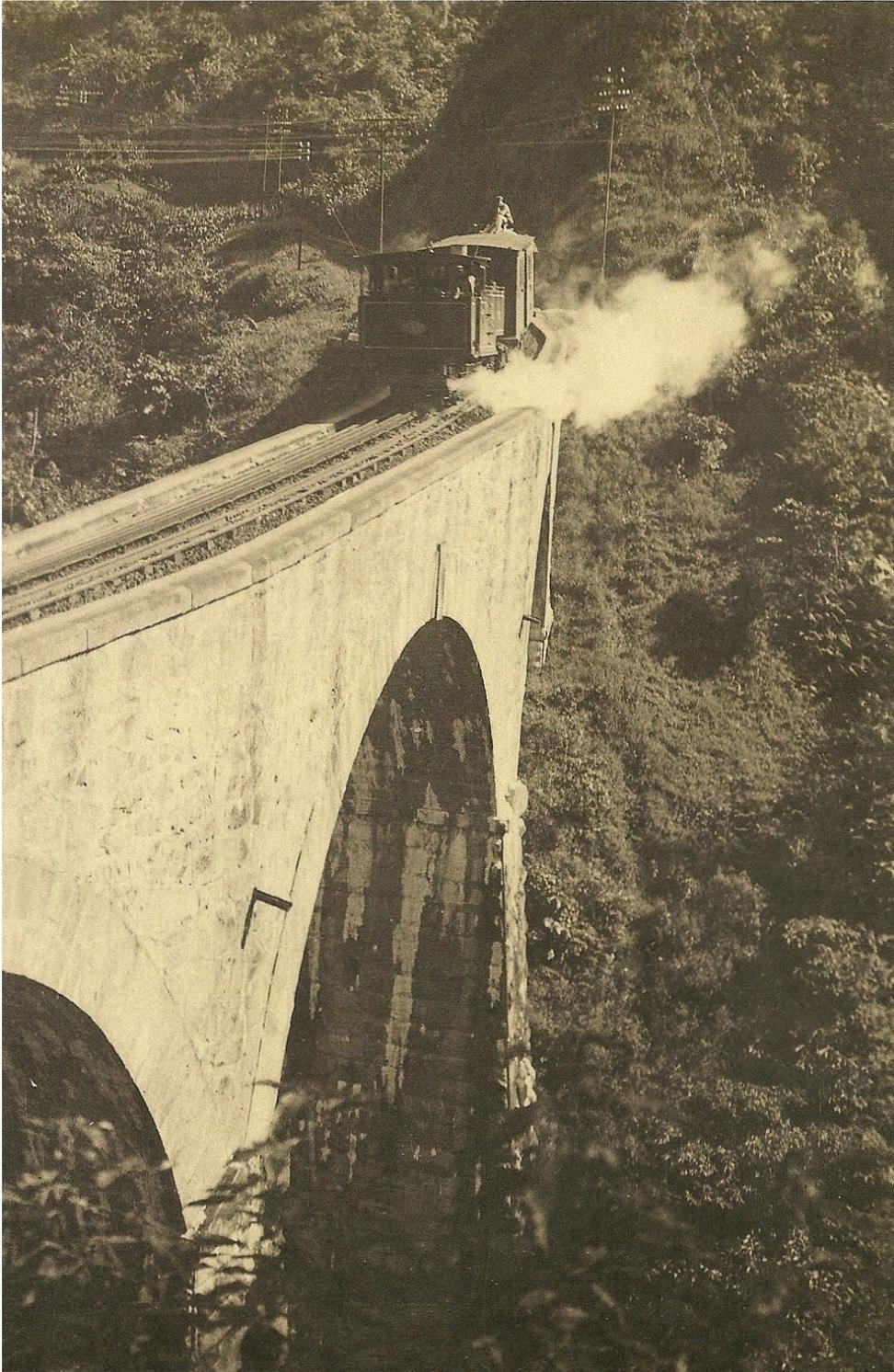
**Figura 7: Locomotiva de cremalheira descendo o Viaduto da Grotta Funda, na Serra da Estrela (RJ), em fotografia de autor anônimo (por volta de 1925) –** Nota-se o trilho central dentado onde era engrenado o sistema motriz da locomotiva de cremalheira e o vapor saindo do freio a vácuo, acionado quando os trens desciam a Serra. Percebem-se também a grande altura das colunas do viaduto, o grande desnível da encosta e a densa vegetação de floresta. Fonte: Gerodetti e Cornejo (2005, p. 17).
