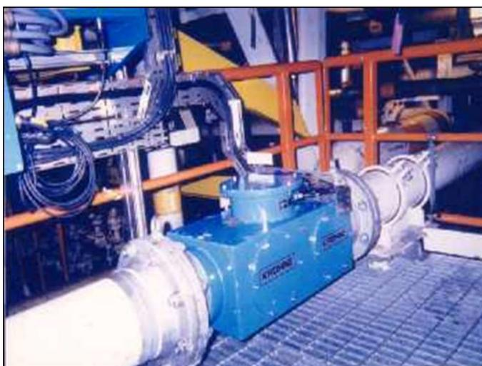
**Figura 12** – Sistema de medição de vazão de petróleo.
