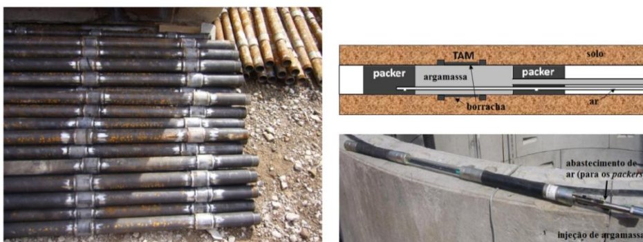
Figura 2.14 - Esquema do equipamento para execução da técnica compensation grouting: (a) tubos de injeção (TAM); (b) componentes do TAM. (Fonte: Bezuijen, 2010).
