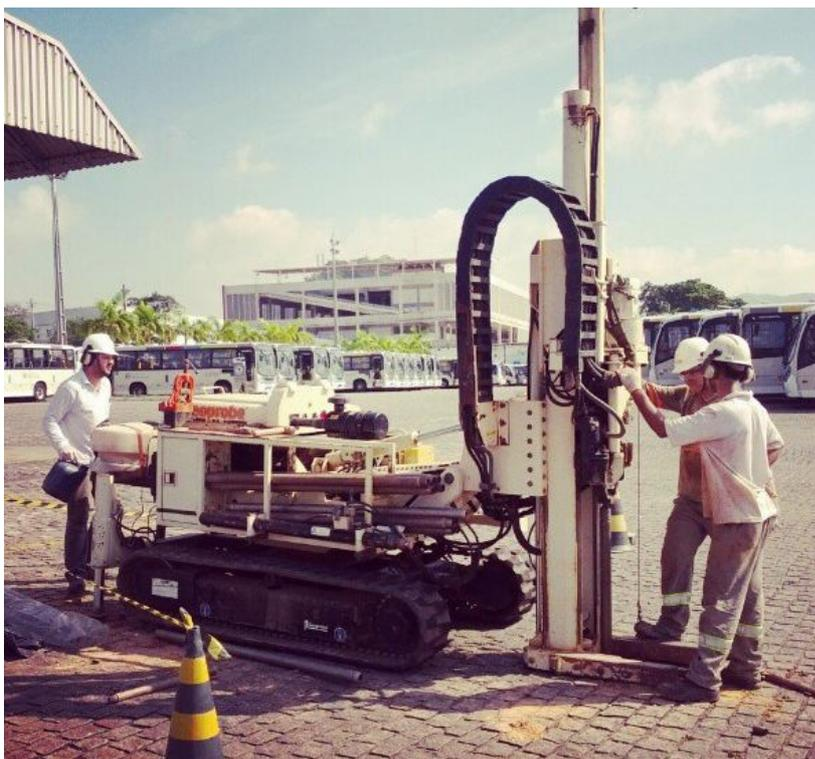
**Figura 2.9: Realização de sondagem ambiental com equipamento mecanizado**
