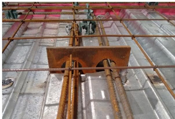
**Figura 4.22 - Detalhe da armadura no “Perfobond”**
