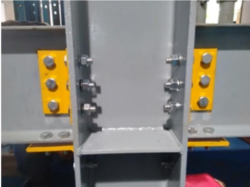
**Figura 4.17 – Detalhe da ligação metálica**
