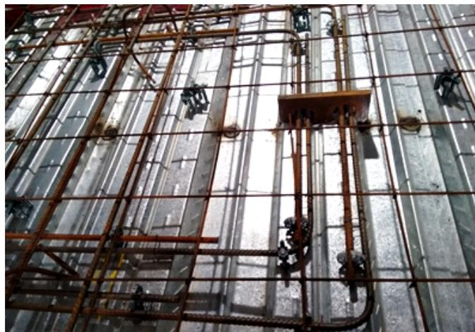
**Figura 4.21 – Detalhe da armação completa**
