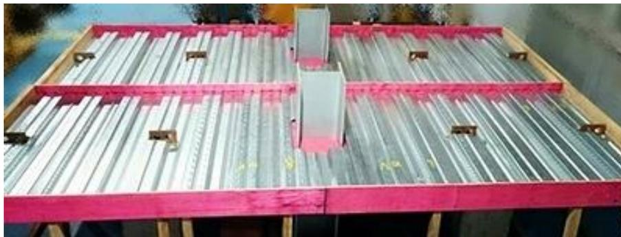
**Figura 4.18 – Detalhe da fôrma de fechamento das lajes**
