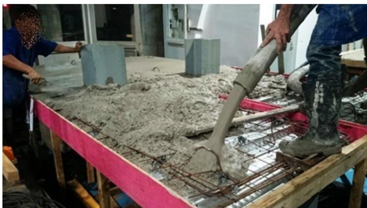
**Figura 4.23 – Concretagem**
