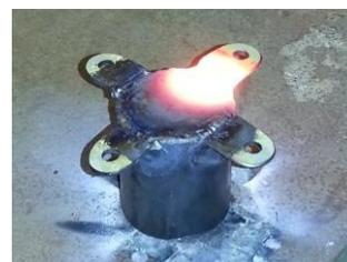
Figura 235 - Conexão dos cabos
