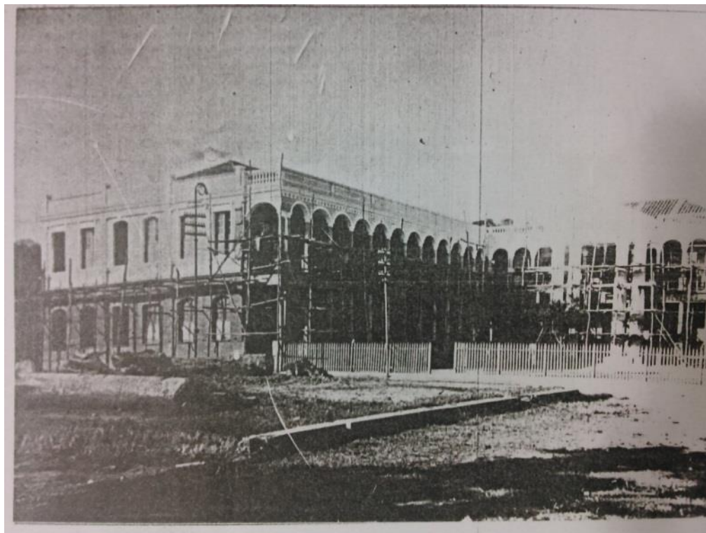
Figura 24 - Trabalhos finais da construção do 2º pavilhão do Ginásio Leopoldinense 96
