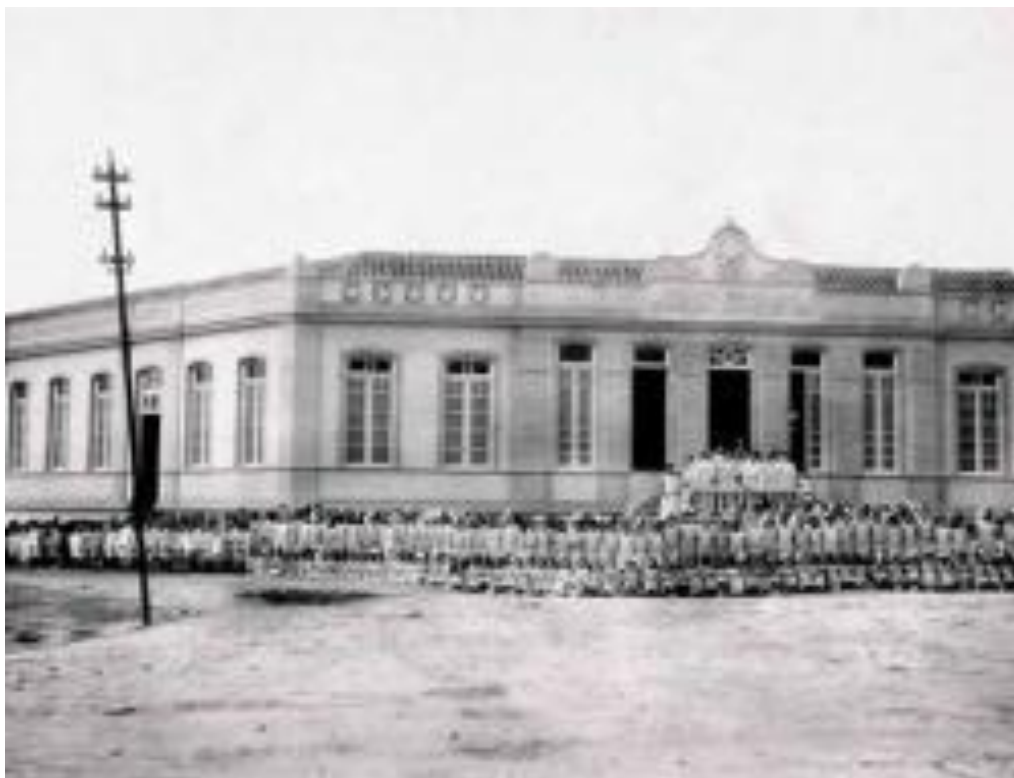
Figura 13 - Novo prédio do Grupo escolar Ribeiro Junqueira. 72
