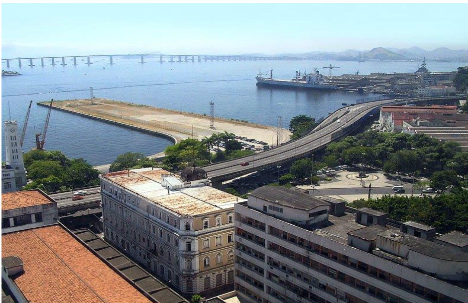
Figura 3: Praça Mauá antes da OUCRPRJ. Destaque para o Viaduto da Perimetral. Fonte: < http://www.skyscrapercity.com/ >. Praça Mauá em 2015 após as obras que compõem a OUCRPRJ.
