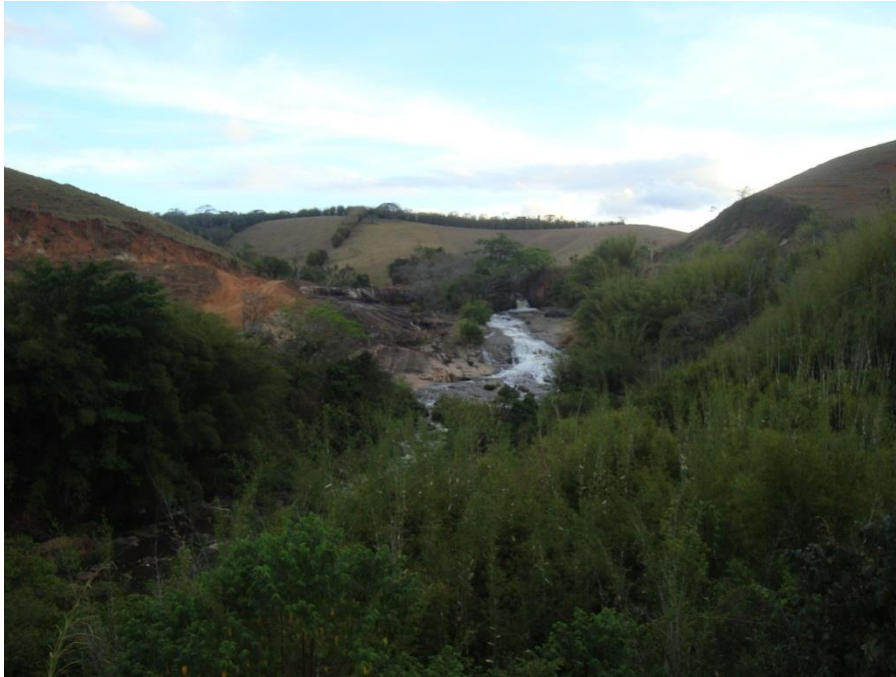
Figura 48: Detalhe do desnível topográfico do Knickpoint no Rio Grande, na margem da Rodovia RJ-152 próximo à Cantagalo.
