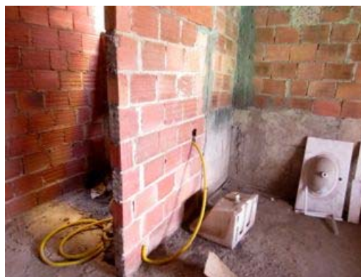
Figura 8.10– Terraço: parte em construção (Família Silva)
