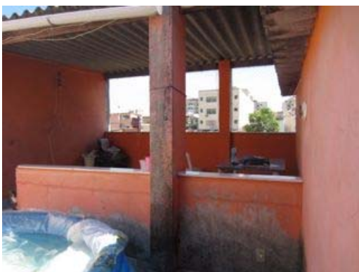
Figura 8.177– Terraço: área coberta (Família Monteiro)
