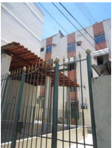
Figura 8.119– Portão do edifício (Família Dias)
