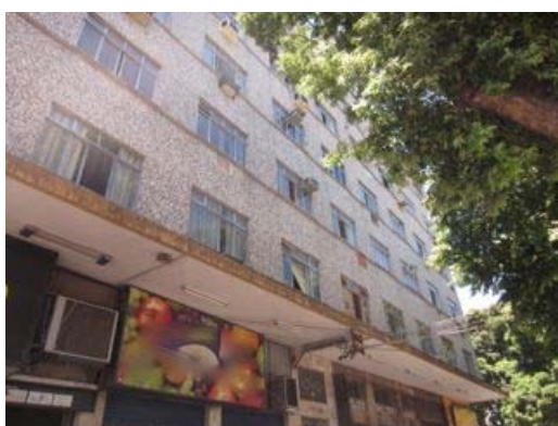
Figura 8.147– Fachada do edifício (Família Cardoso)
