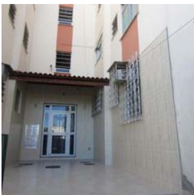
Figura 8.118– Fachada do edifício (Família Dias)
