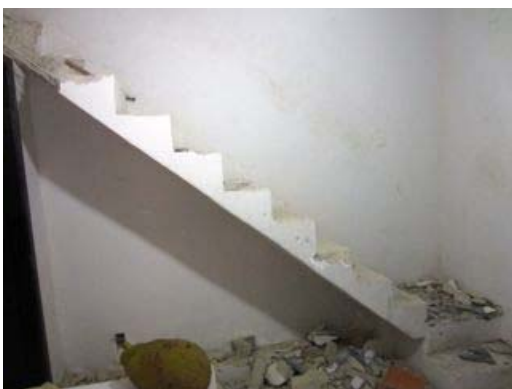
Figura 8.15– Sala: Escada em demolição (Família Santos)
