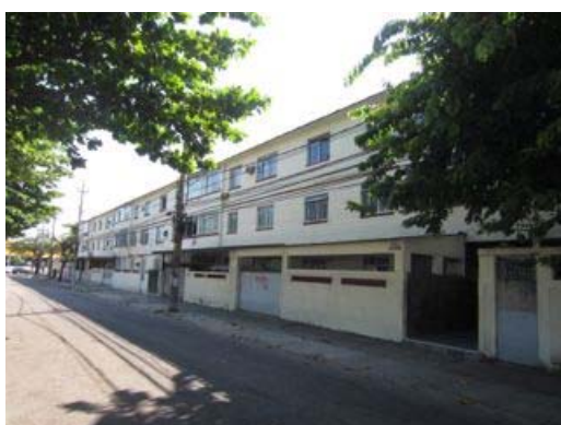
Figura 8.103– Fachada do edifício (Família Ribeiro)
