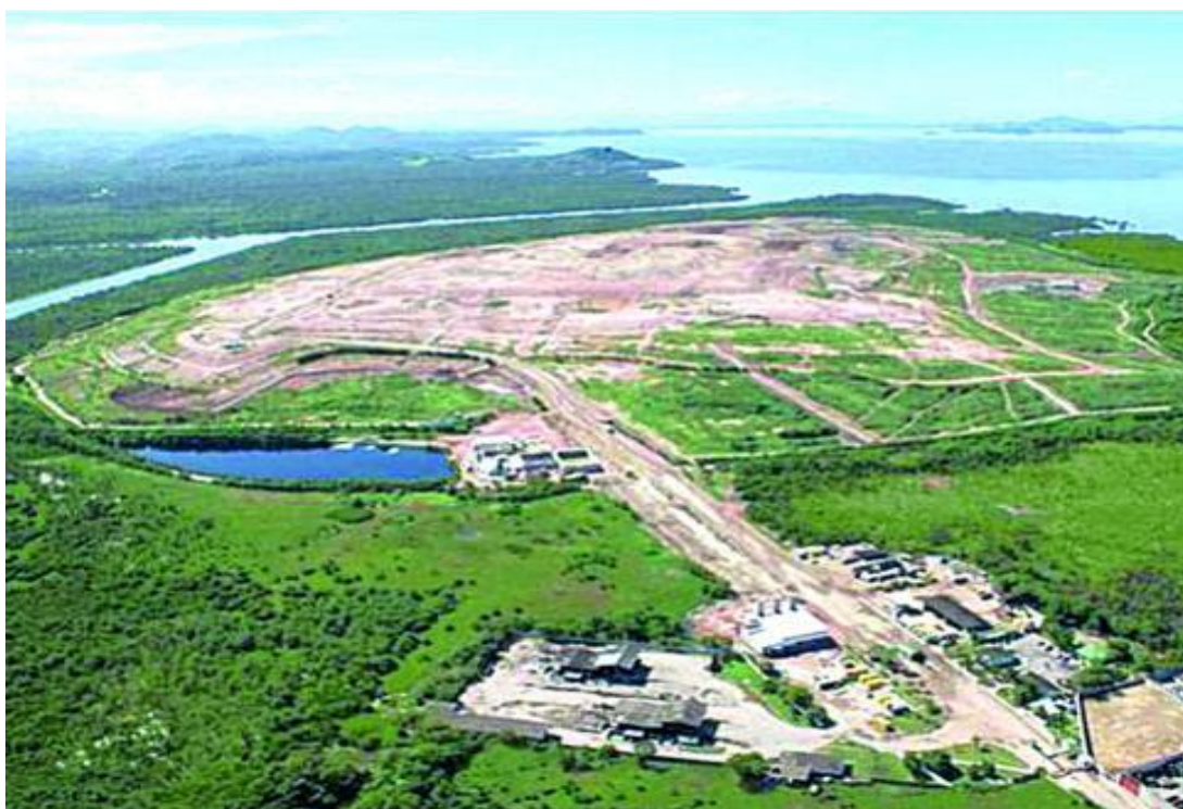
Figura 5: Área de funcionamento do Aterro de Jardim Gramacho.
