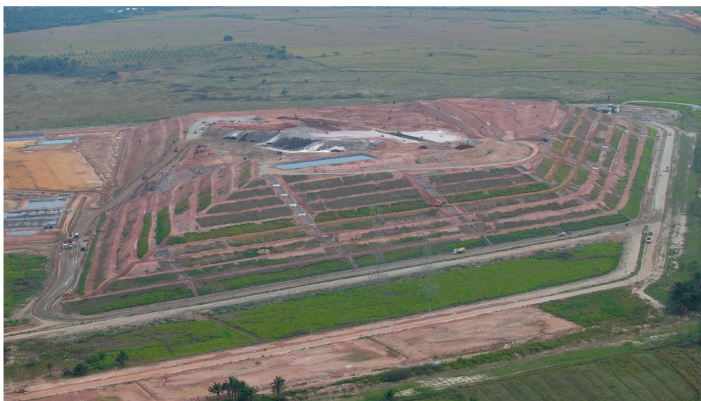
Figura 6: Área de funcionamento da CTR-Rio, no município de Seropédica.
