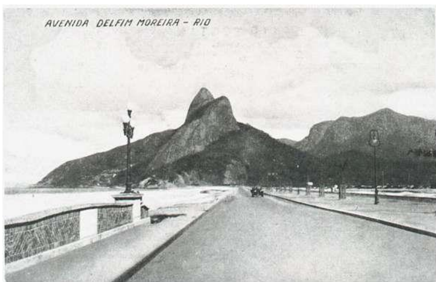
Figura 22: Leblon: estrutura de arruamento pronta apesar dos poucos moradores (1919).
