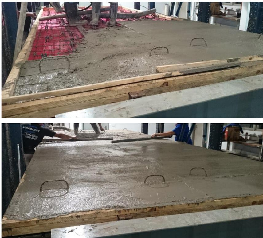
**Figura 4.17 - Concretagem das vigas mistas.**
