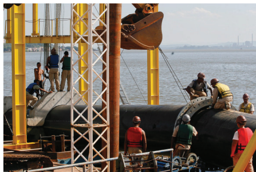
Figura 17. Tubulações de polietileno de alta densidade (PEAD) utilizadas para o transporte de derivados do petróleo [22].
