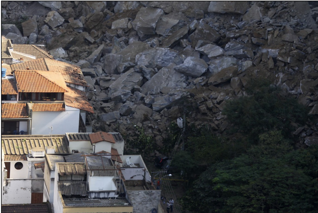
Figura 5.4. Pé do talude observando os blocos de rocha escorregados e a zona residencial (Geo-Rio, 2009)
