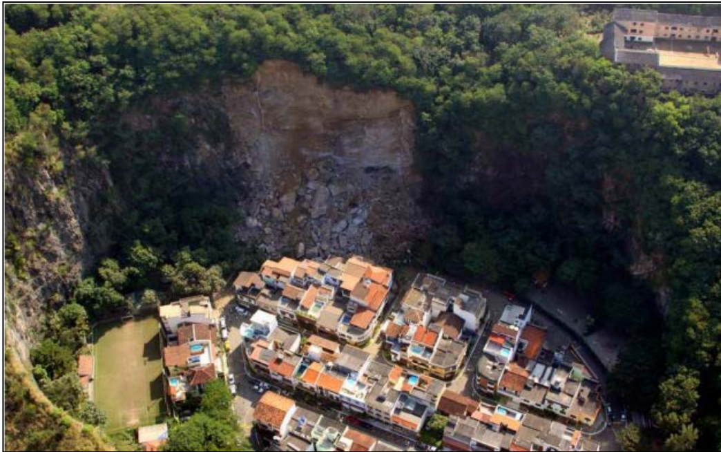
Figura 5.2. Vista aérea do condomínio Jardim Vila Isabel. Na parte central da fotografia se pode ver o talude escorregado (Geo-Rio, 2009).
