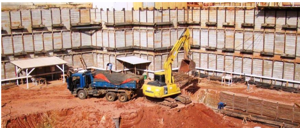
Figura 2.12 – Cortina atirantada do tipo perfil pranchado.
