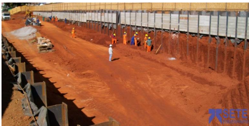
Figura 2.11 – Estrutura do tipo perfil pranchado em construção.
