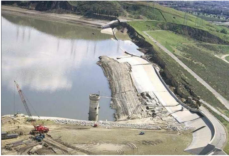
Figura 3.1 - Deslizamento ocorrido na barragem de San Fernando, em 1971 (EERC, University of California, Berkeley, USA).
