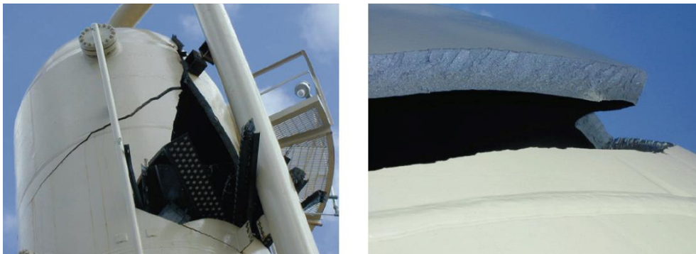
Figura 1.2 – Fratura em vaso de pressão sob teste hídrico.
