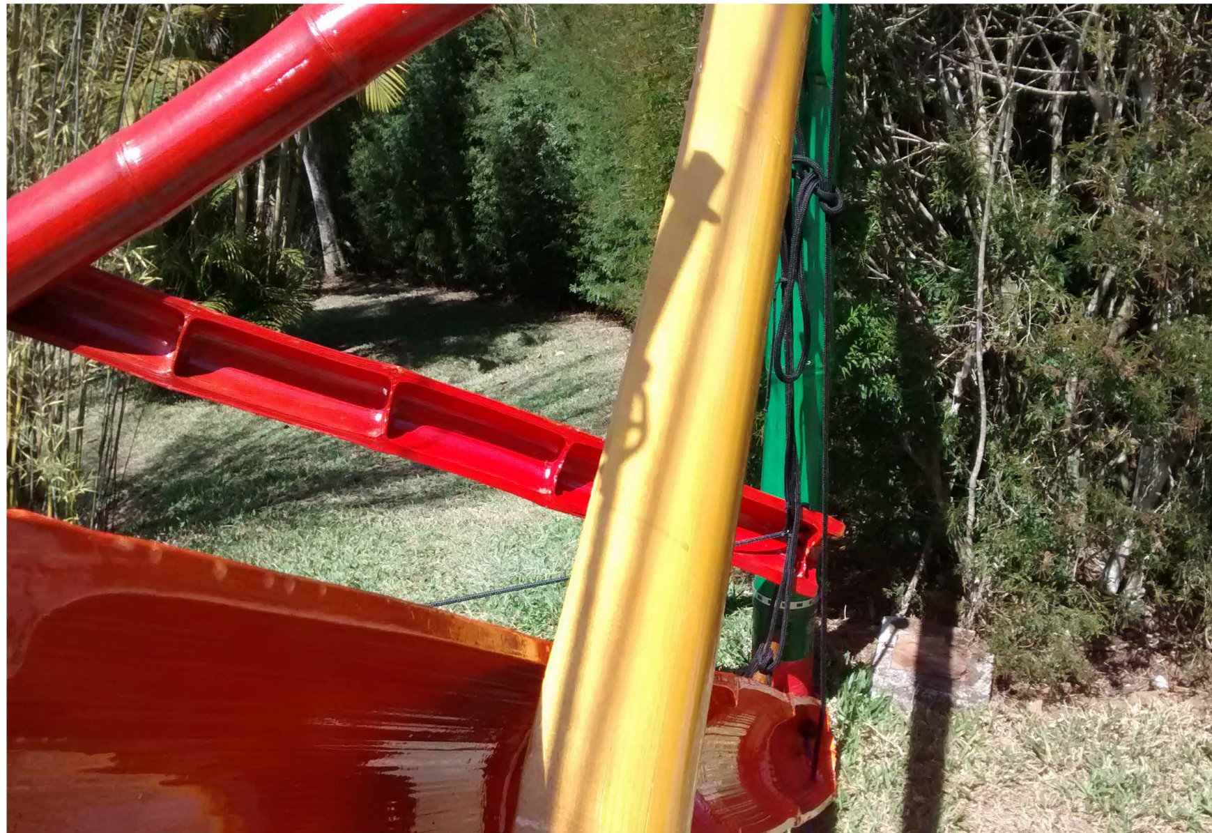
O portão tensegrity de Dendrocalamus Giganteus Asper (laranja e amarelo) substituindo o protótipo Giganteus pintado de vermelho (atrás).
