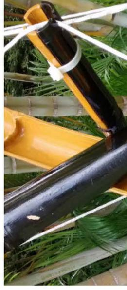
Colunas/batente, formadas pelas duas partes do mesmo bambu, reintegradas por encaixe natural.
