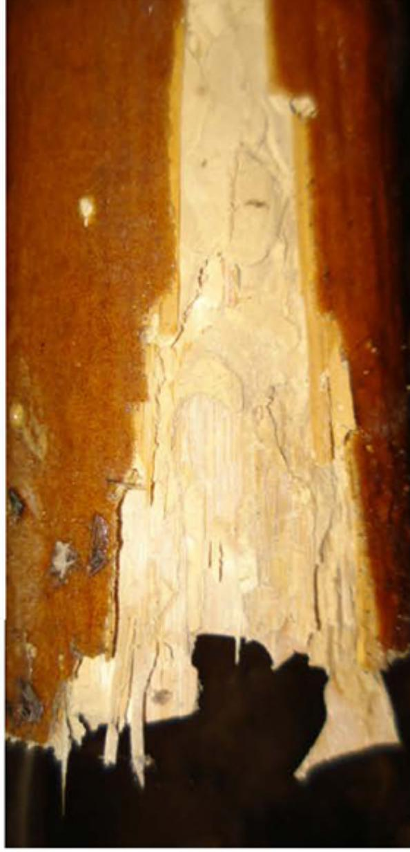
No primeiro semestre de 2014 descobriu-se que os bambus da estrutura de cobertura do LLD que tinham sido encapsulados cinco anos atrás estavam bichados. Polpas destruídas, reduzidas a pó pela ação do besouro Tigre. (*Chlorophorus Annularis Fabricius*). (p.25)
