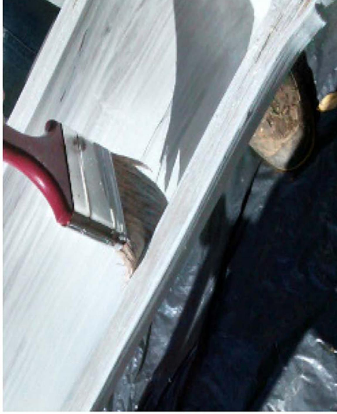
Uma primeira hipótese para prolongamento da vida útil do bambu é encapsulá-lo integralmente, i.e., as duas faces do colmo, impedindo a passagem de ar e provocando a fossilização de ovos entranhados nas fibras. (p.25)
