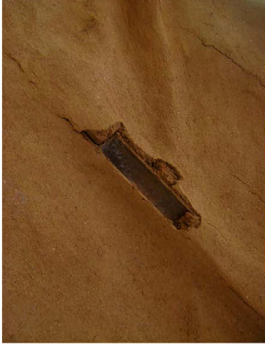
Reentrância esculpida por inseto em parede de barro cru estruturada por bambus e fibras. (p.15)
