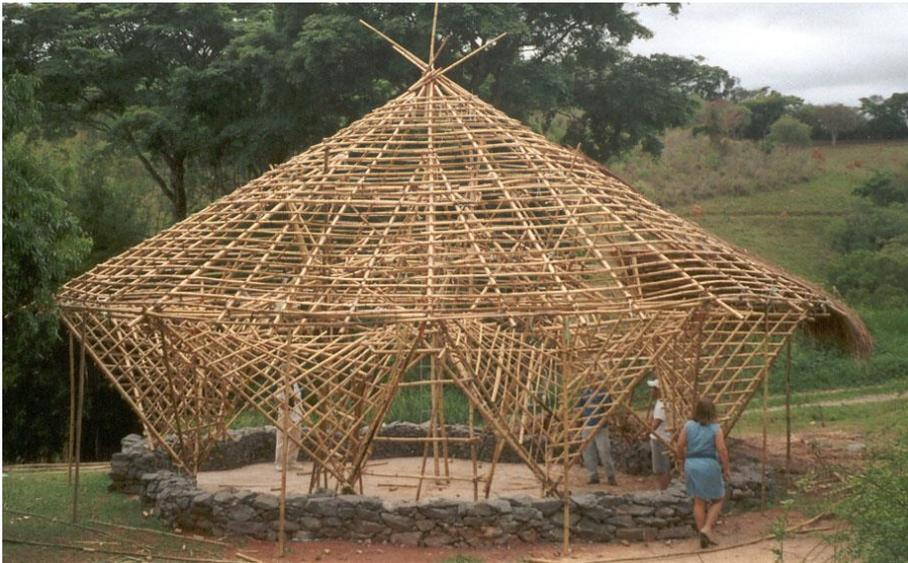
Figura 12: construção de capela de bambu em Andrelandia-MG, uso permanente, 2003.
