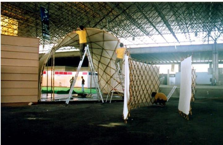
Figura 9: montagem de estrutura treliçada “Túnel”, uso provisório, Bambutec Design, 2004.
