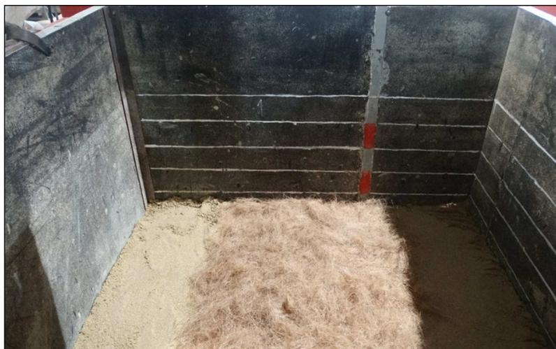
**Figura 4.20 - Colocação da manta de fibra de coco**
