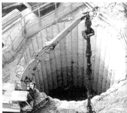
**Figura 2.6** - Parede de estacas secantes para estacionamento subterrâneo (Rasines e Ramos, 2004).
