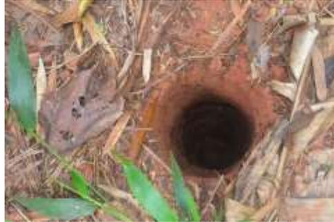
Figura 45: Furo realizado com trado mecânico para instalação do piezômetro de máxima.
