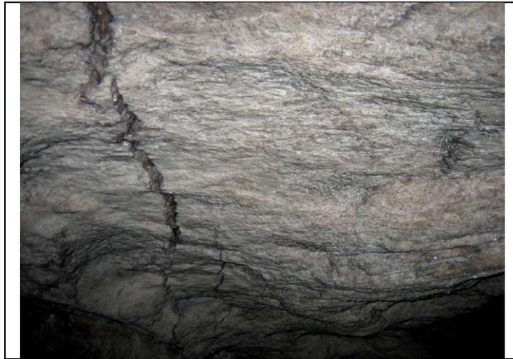
Figura 2.13 – Maciço da mina de Angersdorf com rupturas localizadas (Hampel *et al.*, 2010).
