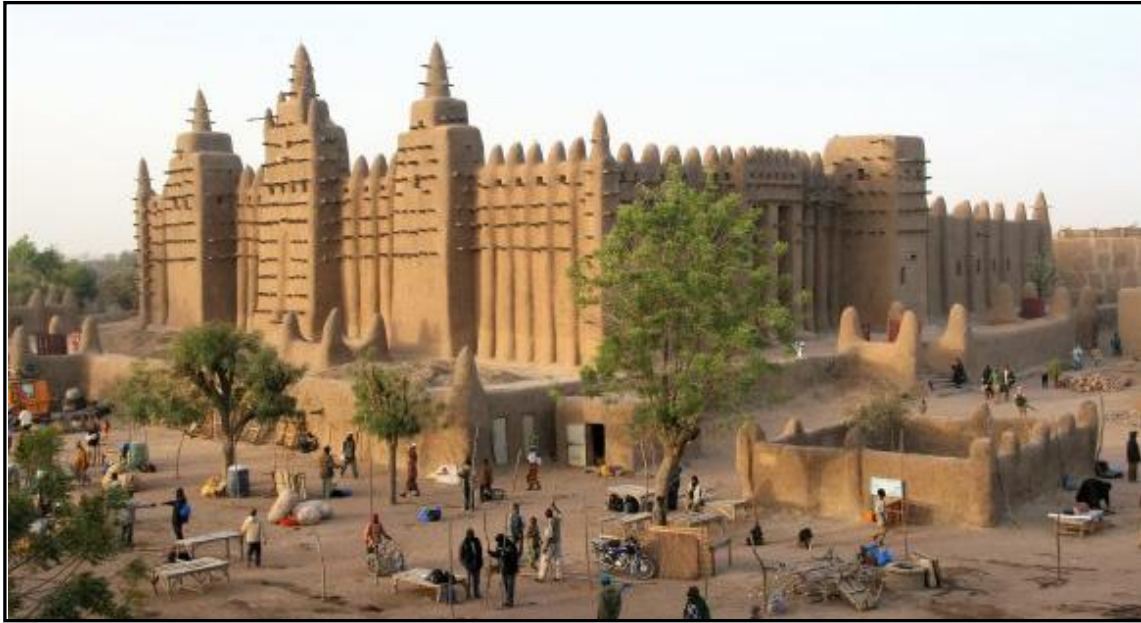
Figura 6. A Mesquita de Djenna no Mali, o maior edifício de adobe do mundo (RECRIAR, 2013).
